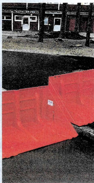
Bordsteine lassen sich mit dem so genannten Gable-Übergang überwinden. Die dreieckigen Seitenwände werden flexibel höhenverstellbar miteinander verschraubt.
