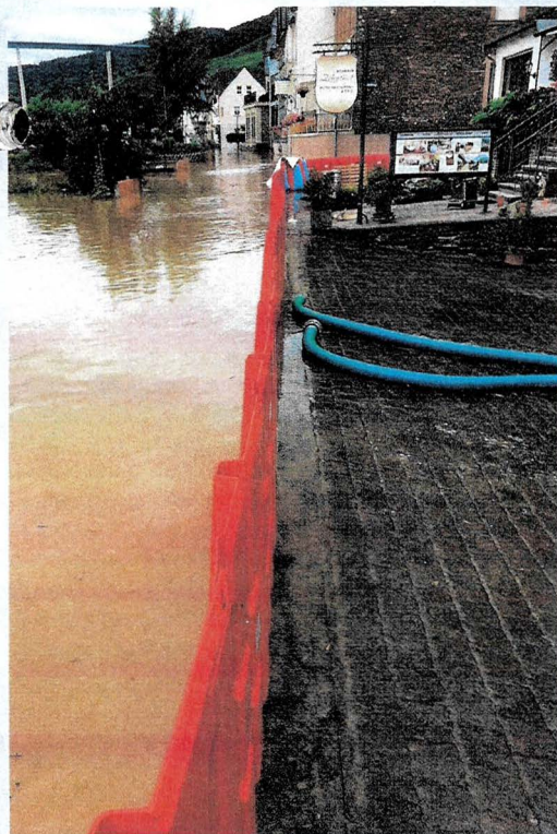
Simulation einer Sturzflut bei Starkregen. Einzelne oder verbundene Elemente des Systems können ausgebracht werden, um die Wassermassen umzuleiten.
